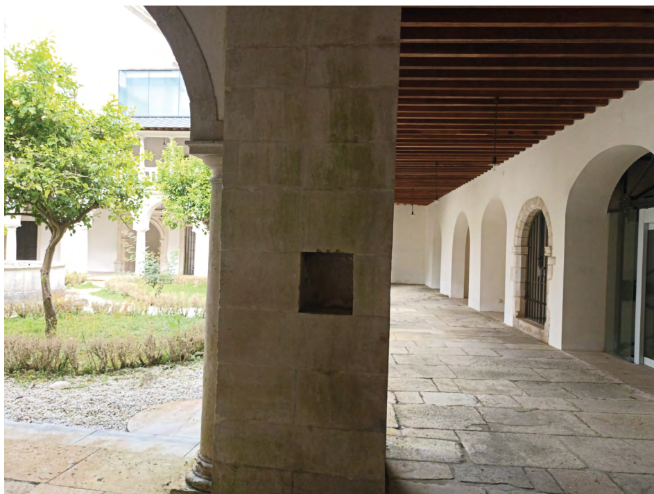
Fig. 2. Claustro de Santa Maria de Lorvão. Puerta del refectorio. Fotografía: M. Pérez Vidal.
